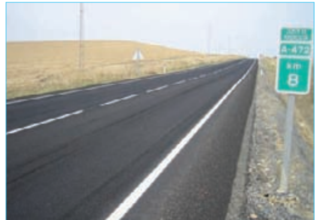
Figura 29. Estado de la superficie de un tramo experimental de lechada bituminosa situada en el PK 8 (LB-3 con 20% de ECL-2d-m, 7% polvo caucho NFU 2-4 mm) en el momento de la campaña de medidas.
