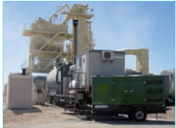
Figura 35. Detalle de la planta asfáltica durante la fabricación de la mezcla BBTM 11A con betún de alta viscosidad con caucho, BMAVC, en Ciudad Real.
