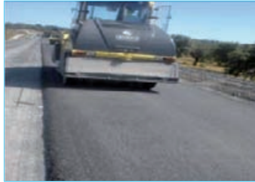
Figura 3. Proceso de compactación y aspecto de una mezcla templada con emulsión.
