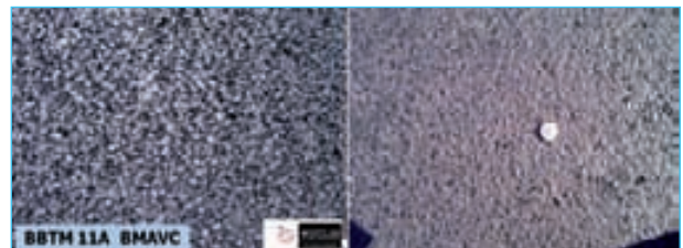
Figura 36. Detalle de la textura superficial de la capa de rodadura recién extendida y al cabo de unos meses.
