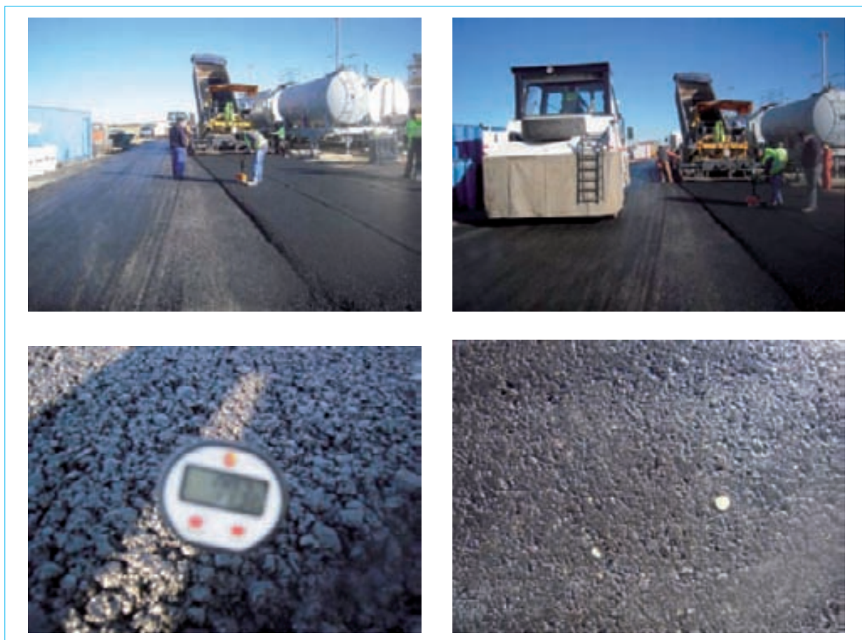
Foto 1. Tramo de prueba inicial para testificación y retroanálisis (Octubre 2010).
