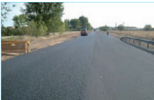
Figura 15. Detalle de la puesta en obra de la capa de rodadura en la CM-3106.
