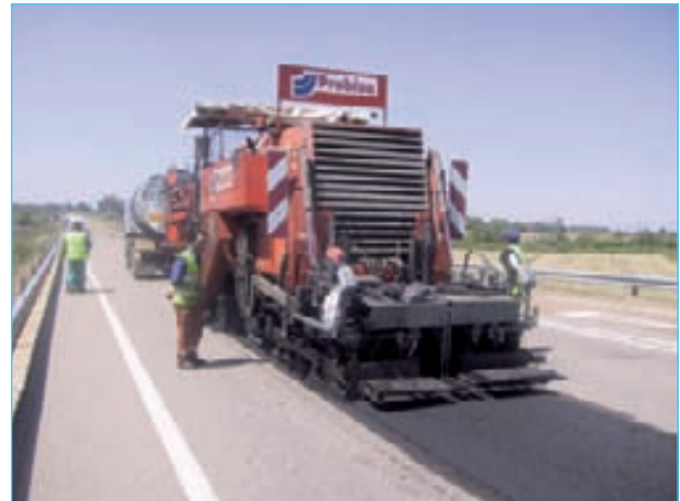
Figura 4. Reciclado en frío con emulsión.
