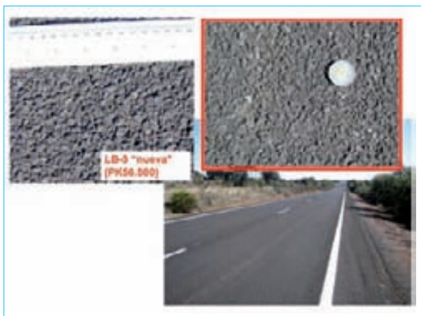
Figura 21. Detalle del tramo experimental y de la superficie de la lechada LB-3 construida en el PK 56+000. En rojo la evolución al cabo de un año desde su puesta en obra.
