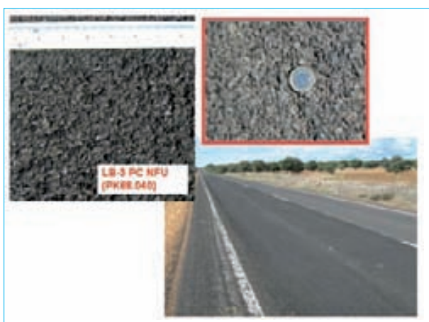
Figura 22. Detalle de del tramo experimental y de la superficie de la lechada LB-3 con polvo de caucho NFU construida en el PK 68+000. En rojo la evolución al cabo de un año desde su puesta en obra.
