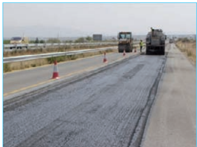
Foto 1. Fresado en dos capas.
