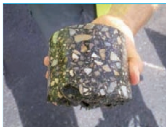
Foto 3. Testigo de obra con MTRTE a tasa total.
